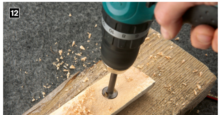
12 Sacklöcher reichen nicht ganz durchs Holz. Man bohrt sie mit einem sogenannten Forstnerbohrer mit Zentrierspitze.
