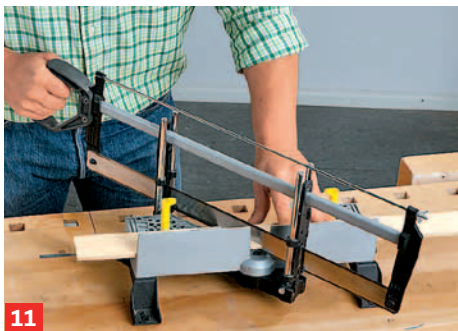
11 Weiter geht es mit dem Leuchtmodul: Mit der Gehrungssäge lassen sich sowohl die beiden Seiten schräg ...
