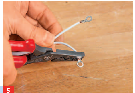
5 Dann die Trafo-Ausgangsleitung abschneiden, abisolieren und Ringkabelschuhe aufquetschen.
