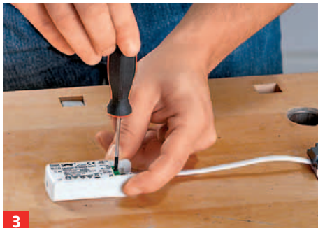
3 Diese Trafo-Zuleitung schließen Sie nun am Ausgang des Infrarot-Schaltelements an. Ein ebenfalls rund 25 cm langes ...
